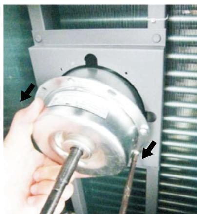
Figure 9-15 Replacing the fan motor
